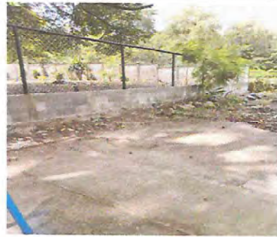
Foto 2: Muro perimetral de block y malla finalizado.
