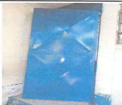
Foto 9: REMOZAMIENTO DE PUERTA DE ACCESO FINALIZADO.
