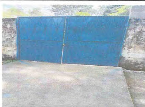
Foto 8: REMOZAMIENTO DE PORTÓN FINALIZADO.
