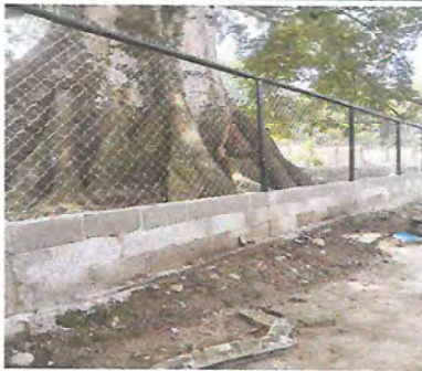
Foto 3: Muro perimetral de block y malla finalizado.
