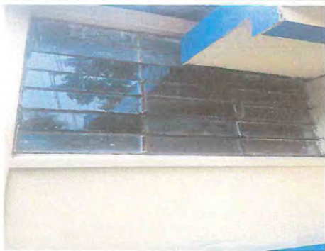
Foto7: SUSTITUCIÓN DE VIDRIOS FINALIZADO.
