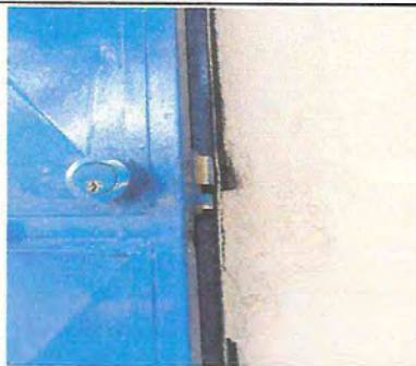
Foto 5: Sustitución de chapas finalizado.
