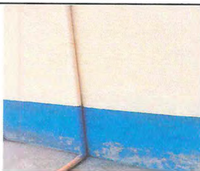
Foto 6: Bajada de agua pluvial finalizada
